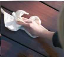
Um Rissbildungen und Ausblutungen an den Schnitt- und Strinkanten zu verhindern empfehlen wir die Verwendung unserer **Hirnholz- und Kantenversiegelung**.
